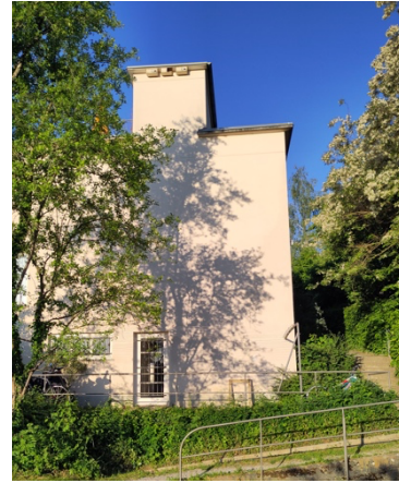
Haus Nr. 57 bedingt geeignet
