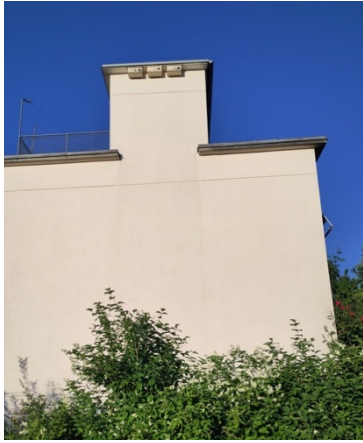
Haus Nr. 73 geeignet
