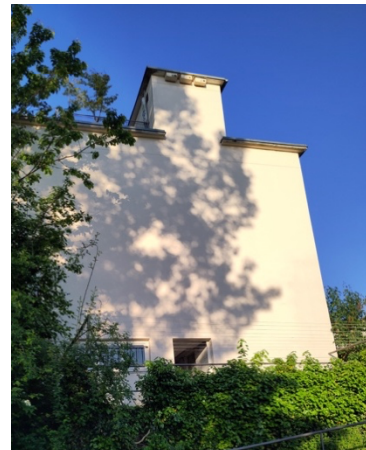
Haus Nr. 33 bedingt geeignet
