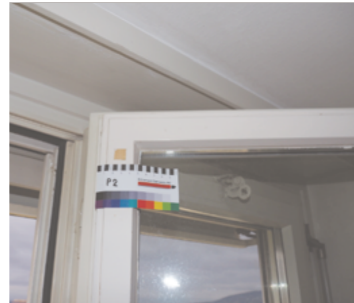
NW-Fassade 1. OG, Ostbühlstr. 18
