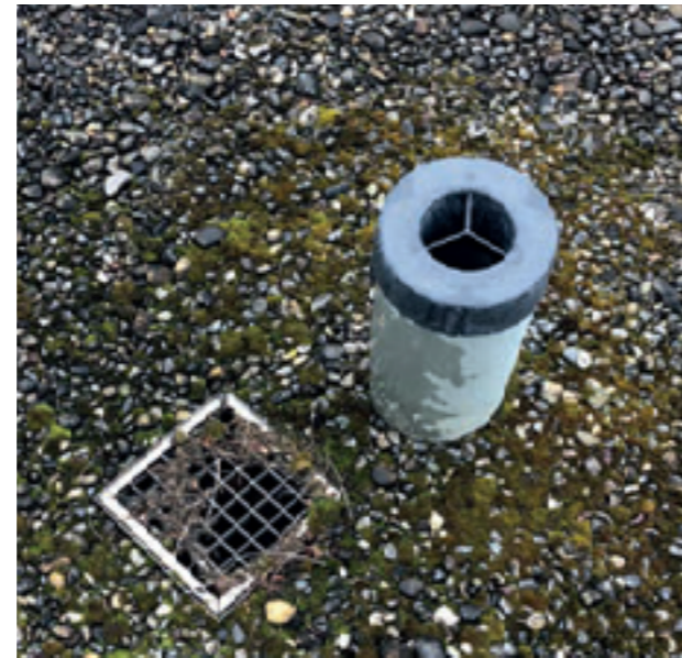
NB79: Dachwassereinlauf, Dunstrohr
