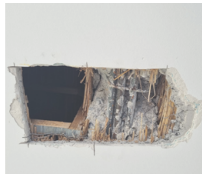
Sondage Armierung: Nidelbadstr. 79, Sitzungszimmer Geschäftsstelle
