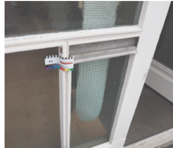
NW-Fassade EG, Ostbühlstr. 18
