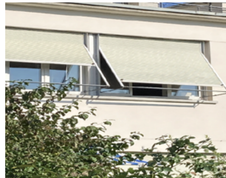
Rollläden Südostfassade Typ A, Foto: GFA 2024
