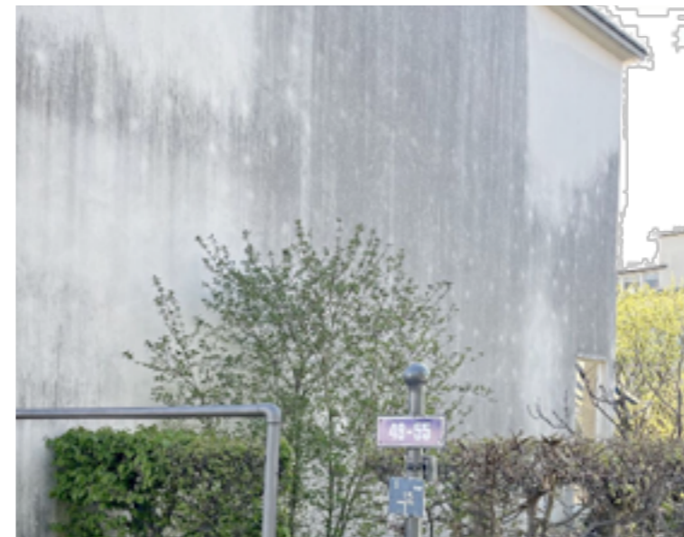
Stirnfassade Typ A, Ostbühlstrasse 49-55, Foto: Katrin Oechslin, 2025
