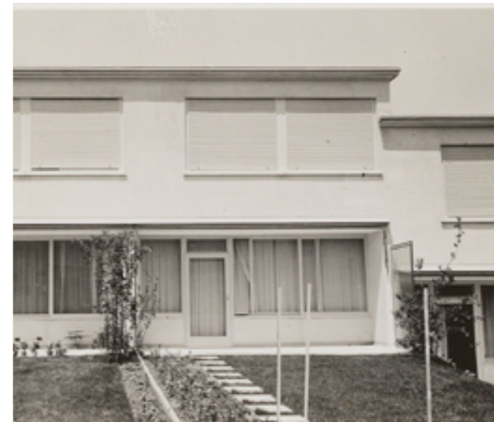
Südostfassade vor 1945, Quelle: gta Archiv / ETH Zürich, Dauerleihgabe Genossenschaft Neubühl
