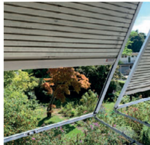
OB32: Ausgestellter Rollladen von innen
