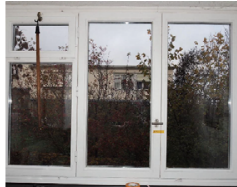
Nordwestfassade, Küchenfenster 1980er, Typ B, Ostbühlstrasse 44, Quelle: Eigenmann AG
