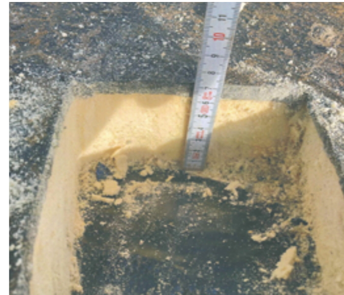
Sondage Flachdach: Westbühlstr. 27-41, 60mm PU Isolation
