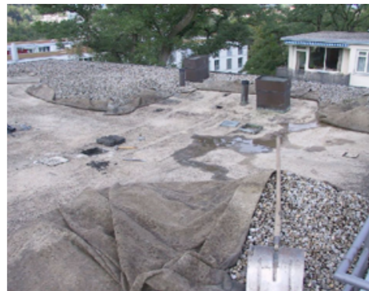
Dacharbeiten, Quelle: Baufotos Th. Zangger, 2002
