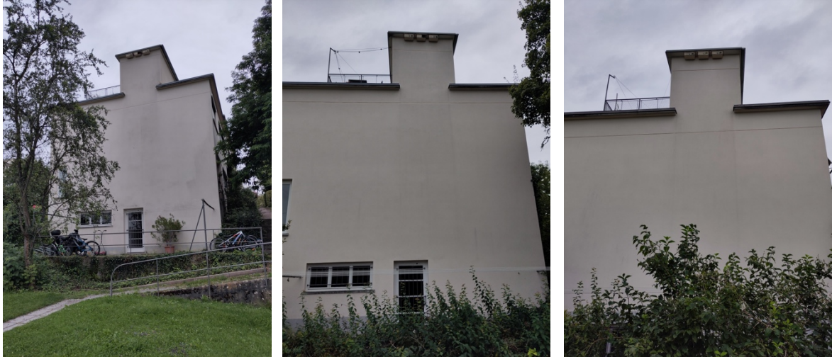
Abb. 1 (Fortsetzung): Die Häuser Ostbühlstrasse 57, 65, 73 mit je drei Mauersegler-Nistkästen.
