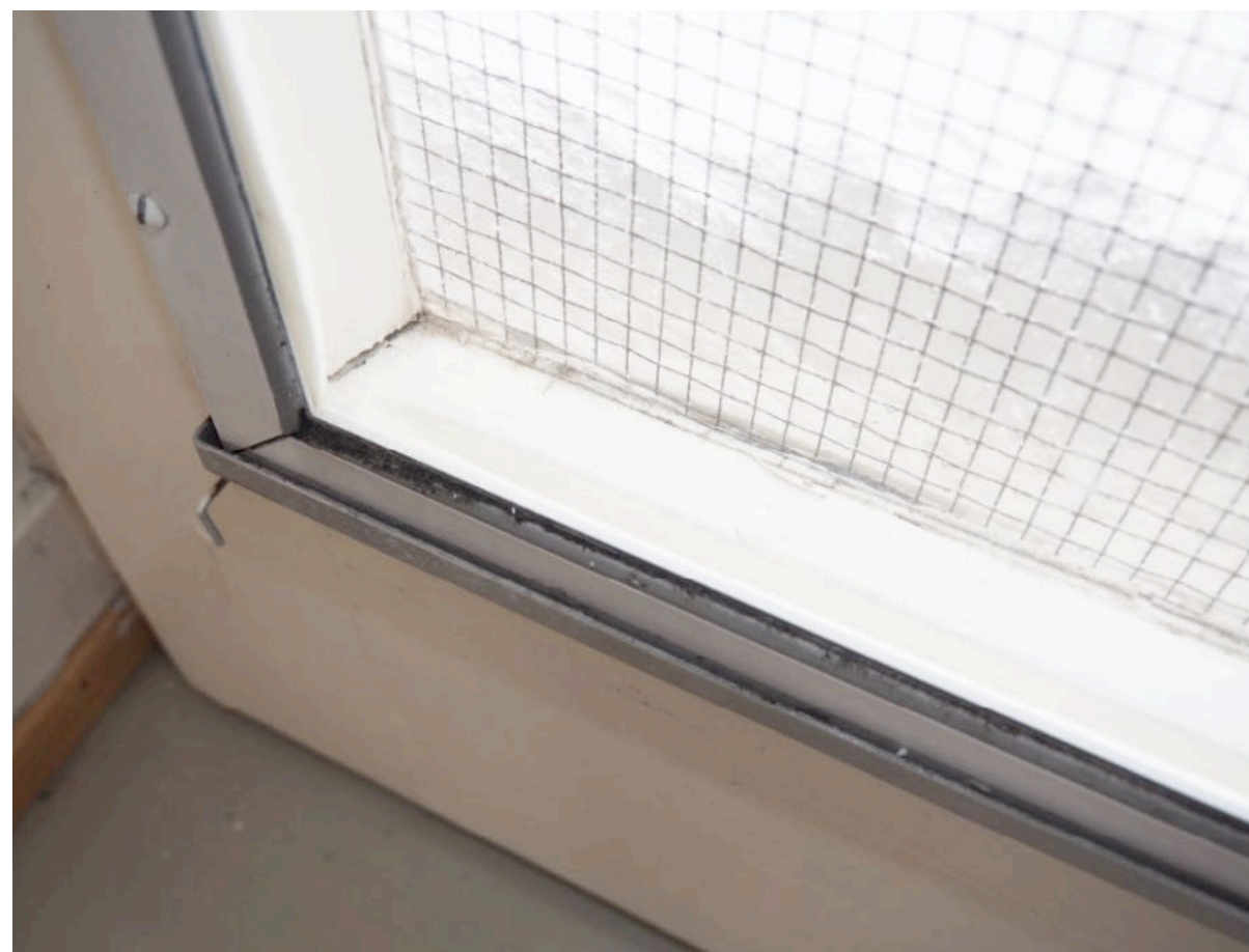
Detail Aufsatzrahmen mit Ablaufschiene Eingangsbereich Typ O, Kalchbühlstrasse 150a, Quelle: Eigenmann AG
