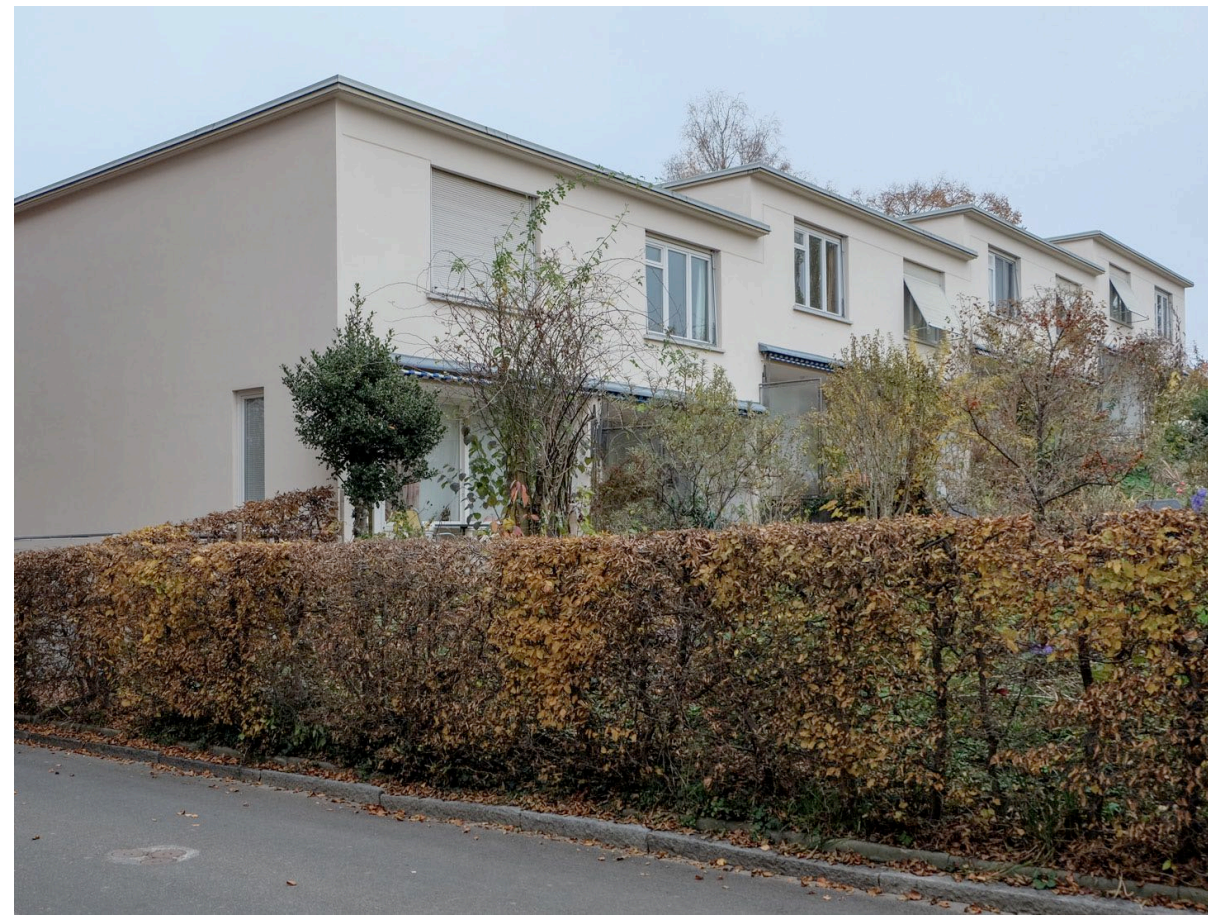
Südostfassade Typ B, Quelle: www.architecture.eu
