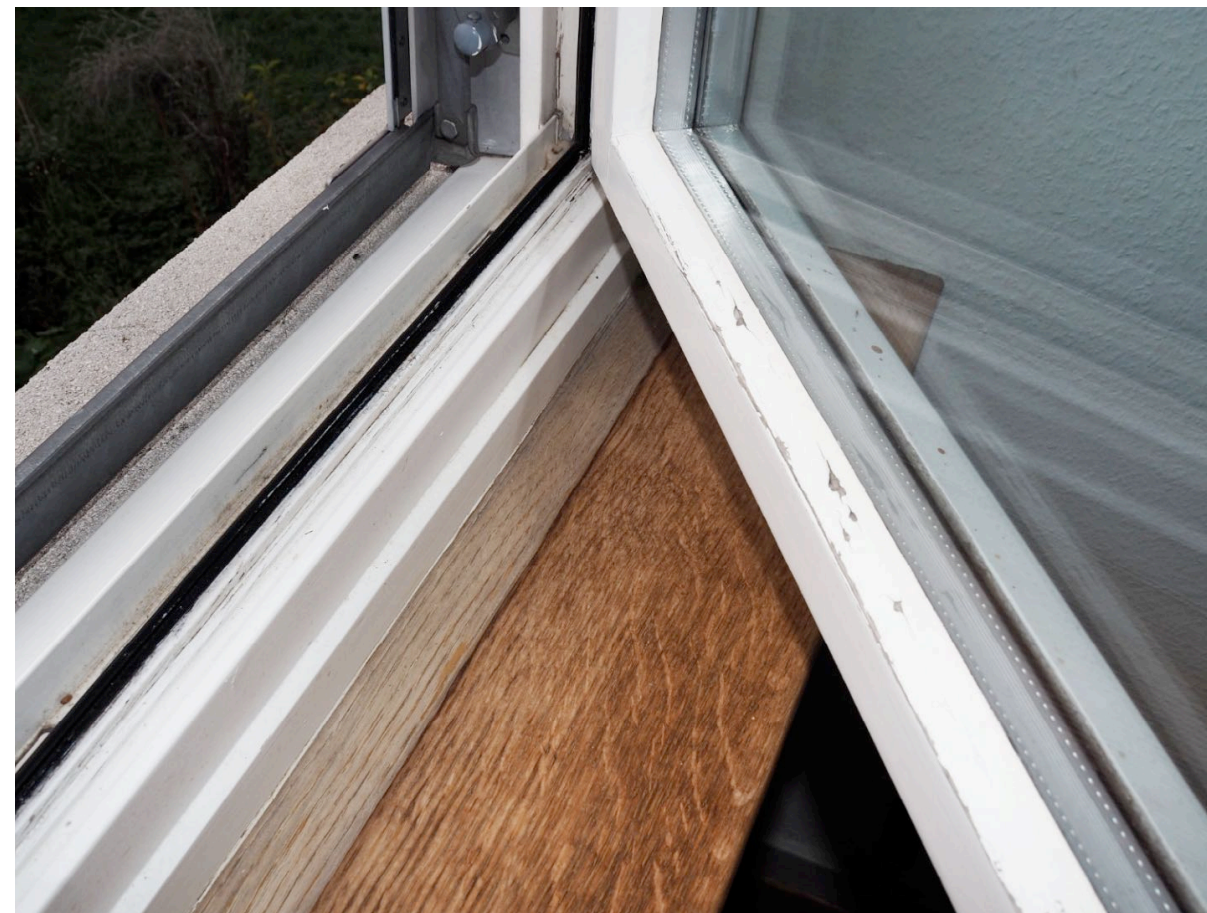
Fensterprofil mit Isolierglas und Anschlagdichtung, Ostbühlstrasse 18, Quelle: Eigenmann AG
