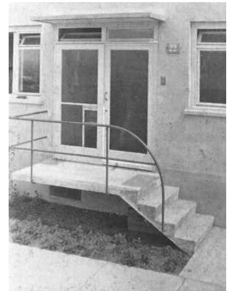
Aussentreppe ohne Eckstütze
