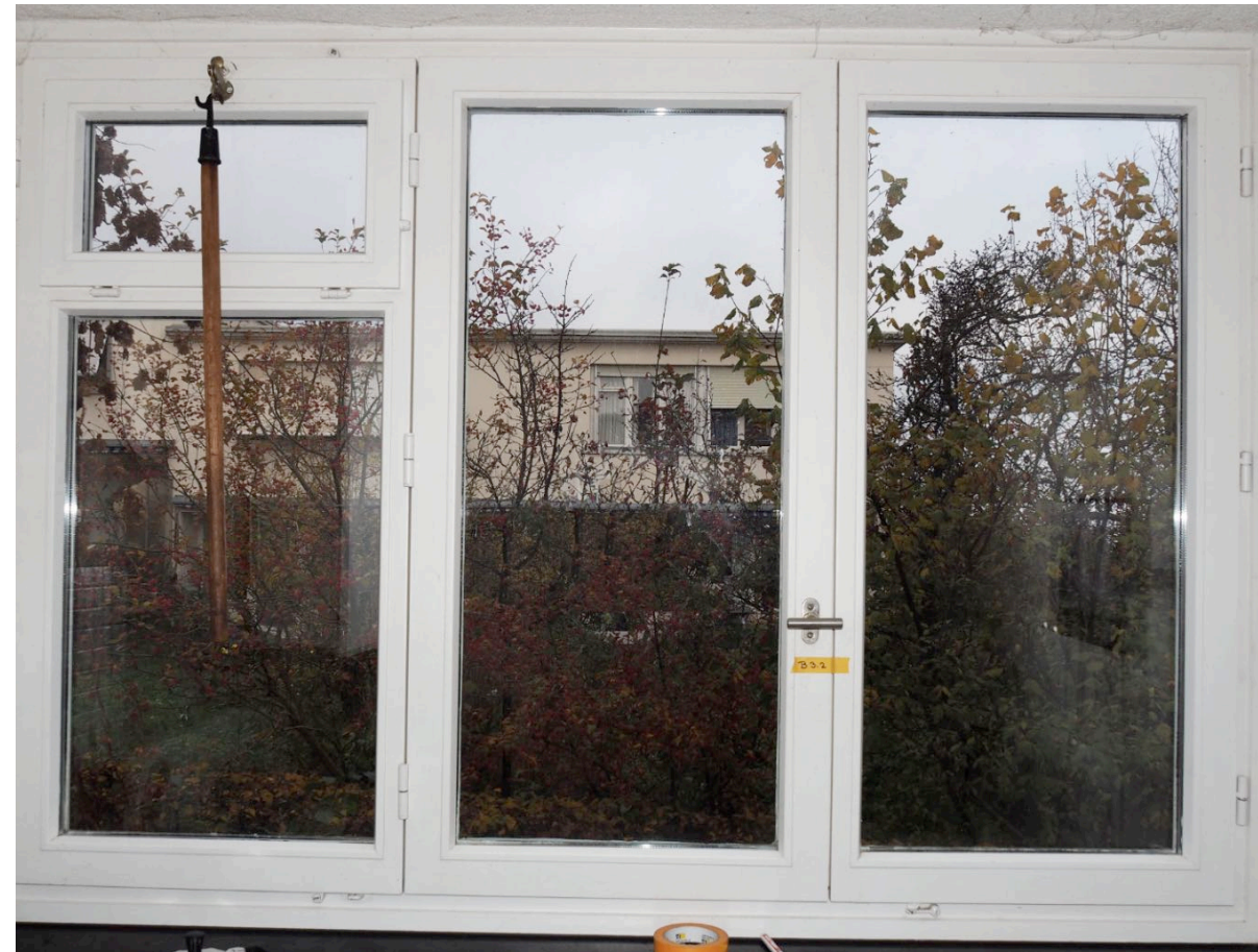
Nordwestfassade, Küchenfenster 1980er, Typ B, Ostbühlstrasse 44, Quelle: Eigenmann AG
