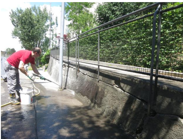
Sanierung Stützmauer – loser Putz wird mit Hochdruck entfernt
